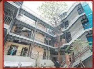
■建築群的懷舊油磚、走廊鐵欄、窗戶及木門，保留原來古味。
