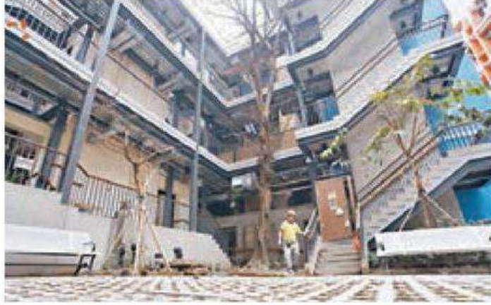
■ 藍屋復修項目即將完工。
